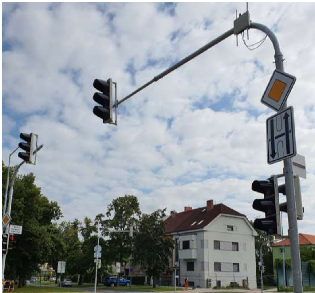
Foto instalace nové signalizace na křižovatce Sukova - Schwarzova (Zdroj: Ing. Josef Brůha, SVSmP)
